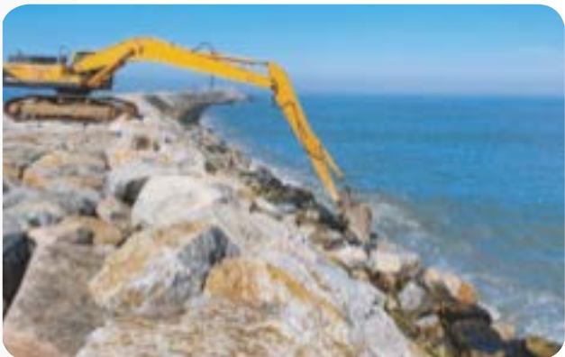
Confortement de la digue sud du port de Mehdia
