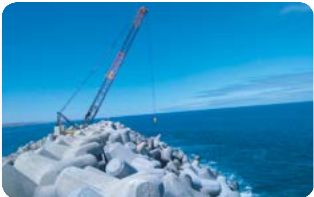
Confortement de la jetée principale du port de Jorf Lasfar
